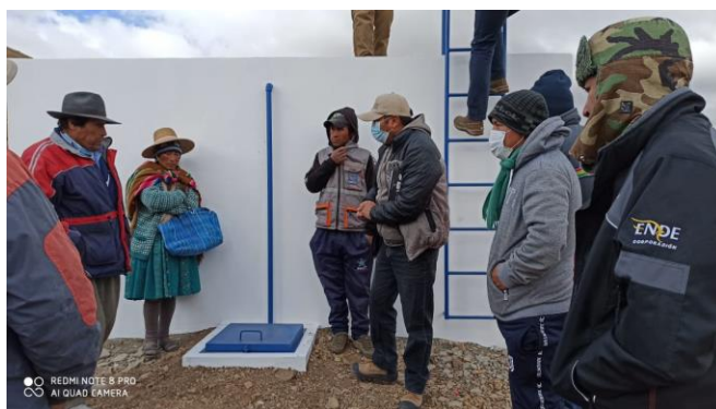
Seguimiento a la obra por el CRP Proyecto de agua potable CONST. SIST. AGUA POTABLE MOROCOYO (CHALLAPATA)
