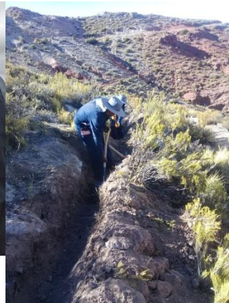
Excavación red de aducción Comunidad Pueblo Viejo CONST. SIST. AGUA POTABLE PUEBLO VIEJO (MOJINETE)
