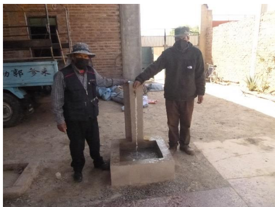
Pileta Domiciliaria en proyecto "MEJ. SIST. DE AGUA POTABLE BARRIOS 18 DE MAYO (VILLA PUNATA)" - Cochabamba
