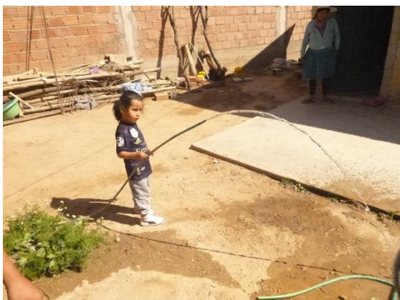
Verificación de funcionamiento en proyecto "MEJ. SIST. DE AGUA POTABLE Z. CONVENTO TARATA (TARATA)" - Cochabamba
