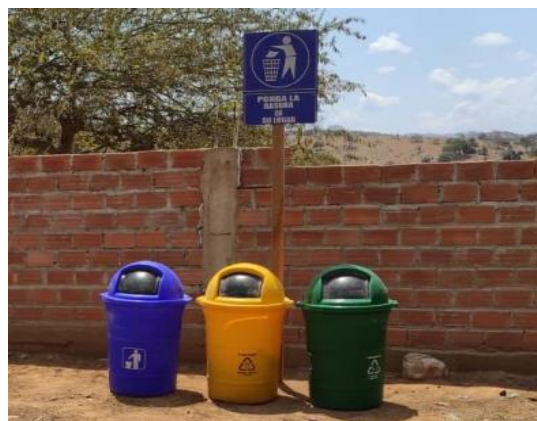
Contenedores de residuos sólidos en áreas de campamento del proyecto "Const. Sist. De Agua Com. Montecillo Sud (Tiquipaya)"
