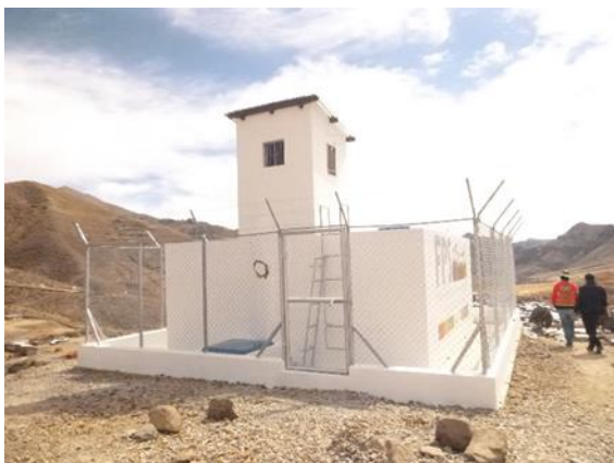
Tanque de Almacenamiento en proyecto "CONST. SIST. AGUA POTABLE CENTRAL QAQACHACA (CHALLAPATA)" - Oruro
