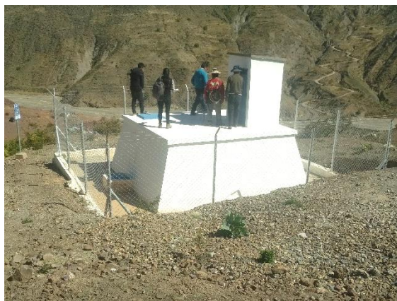
Tanque de Almacenamiento en proyecto "CONST. SIST. AGUA POTABLE TOCORIA (CHUQUIHUTA)" - Potosí
