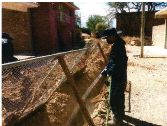
Humedecimiento del área de excavación en proyecto "Mej. Sist. Agua Potable Sorata - Pueblo Nuevo (Sipe Sipe)"
