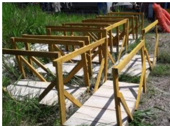
Pasos peatonales a ser instalados en áreas de excavación del proyecto "Const. Sist. De Agua Potable Cinco Unidos (Rurrenabaque)"
