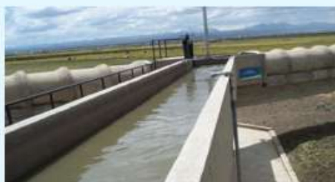
Zanjas excavadas para instalación de tuberías de Alcantarillado Sanitario
