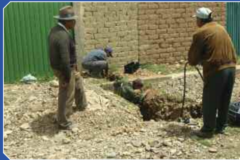
Vecinos de San Francisco, Distrito 7, instalaron casi 4.000 conexiones domiciliarias de agua.
