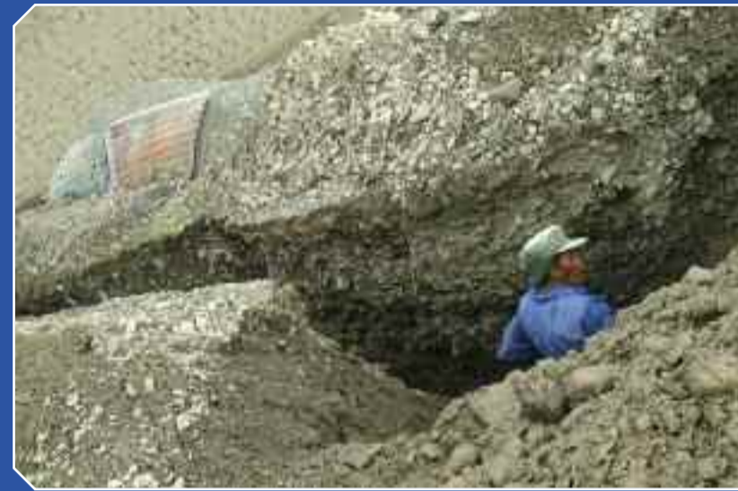
Un obrero abre zanjas para instalar las últimas tuberías de alcantarillado sanitario en el Distrito 7.
