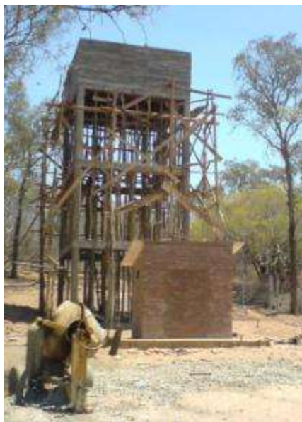
Construcción de un tanque de agua en el Chaco tarijeño. (Foto DNR)
