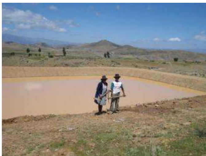
Un atajado que se construyó en Yamparáez, Chuquisaca, con recursos de emergencia del Tesoro General de la Nación para mitigar los efectos de los desastres naturales. (Foto DNR)
