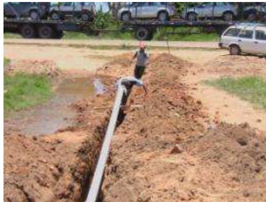
En el Municipio de San Carlos, Santa Cruz, dos obreros extienden la tubería de agua potable que se construyó con apoyo del Gobierno Nacional.
