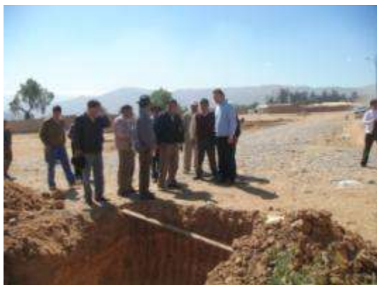
Autoridades del MMAyA inspeccionan el avance físico de obras en la construcción del sistema de alcantarillado en la zona sur de la ciudad de Cochabamba.
