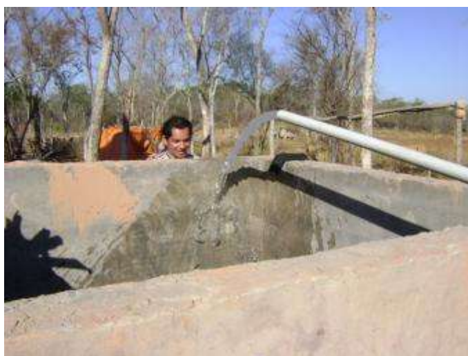
Un estanque de agua construido en el chaco Tarijeño
