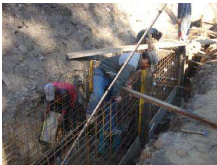
Obreros trabajan en el cimientado del sistema de riego que se construye en el Municipio de Villa Serrano, Departamento de Chuquisaca. (Foto Dirección Nacional Riego)
