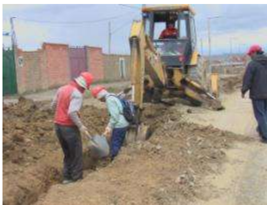
Una excavadora y obreros cavan una zanja para las tuberías de agua potable en El Alto.
