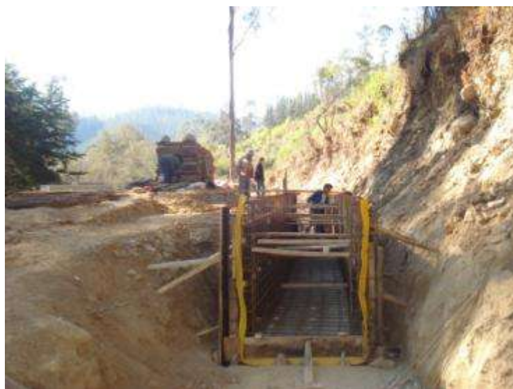
La obra de la presa del sistema de Villa Serrano, del Departamento de Villa Serrano en toda su amplitud. (Foto Dirección Nacional Riego)
