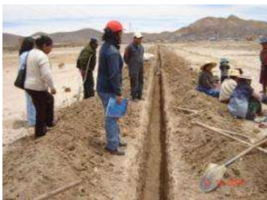
Una zanja para la red matriz de agua potable se extiende en el norte de la ciudad de Oruro.
