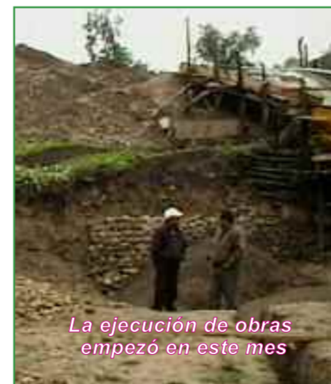
Construcción de canales de la represa
