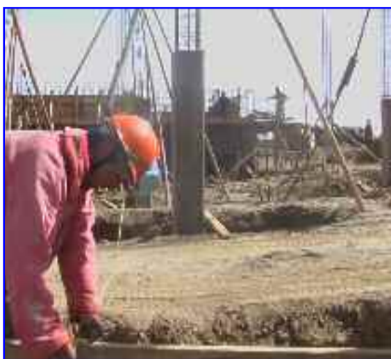
Obreros y técnicos construyen en Puchukollo hormigones y bases de los equipos que procesarán las aguas residuales de El Alto.
